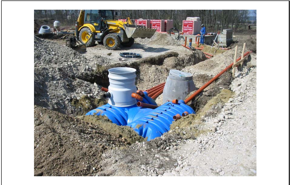
Abbildung 9: Regenwasser-Tanks
