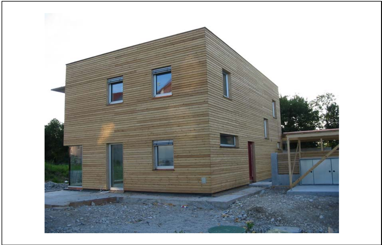
Abbildung 5: SO- und NO-Fassade
