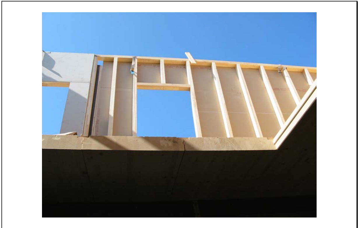
Abbildung 3: Montage der SW-Wand im Obergeschoß
