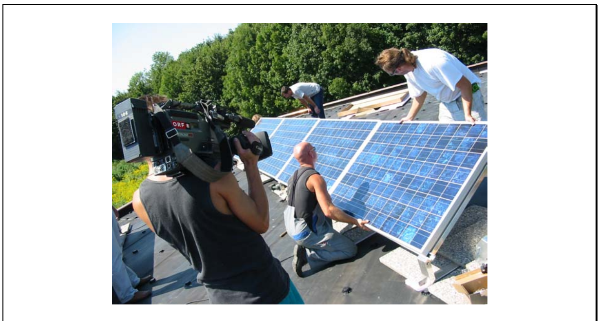
Abbildung 2: Montage der PV-Anlage im Beisein des ORF
